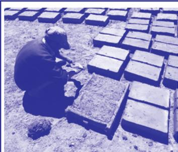
Pour transformer la terre en murs, on peut mouler des briques de terre crue, puis on les fait sécher au soleil, ce qui ne consomme presque pas d'énergie. Pour faire du pisé, on tasse la terre entre des planches. Fabriquer des briques de terre cuite dépense de l'énergie.
