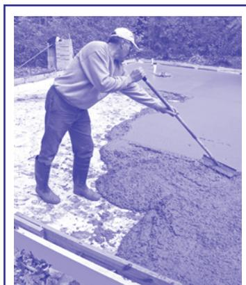
A la pose, couler le béton est assez facile et rapide, dans un moule ou entre des planches (coffrage). Il permet de construire des formes compliquées et solides, rapidement et pas cher.
