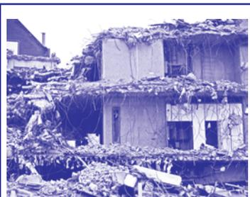
Le béton est rarement recyclé car il faut d'abord le récolter sur les chantiers de démolition, puis séparer les aciers et casser le béton (consommation d'énergie). Les morceaux sont entassés sur des terrains, comme des montagnes de déchets.
