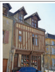
Maison à colombages, mur en bois et en torchis (mélange de terre crue et de paille).
