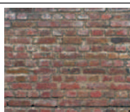
Mur en briques.
