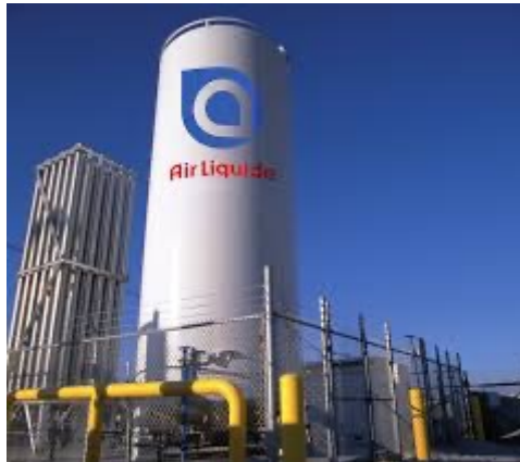
Installation de stockage cryogénique d'azote liquide. Source : Air Liquide®
