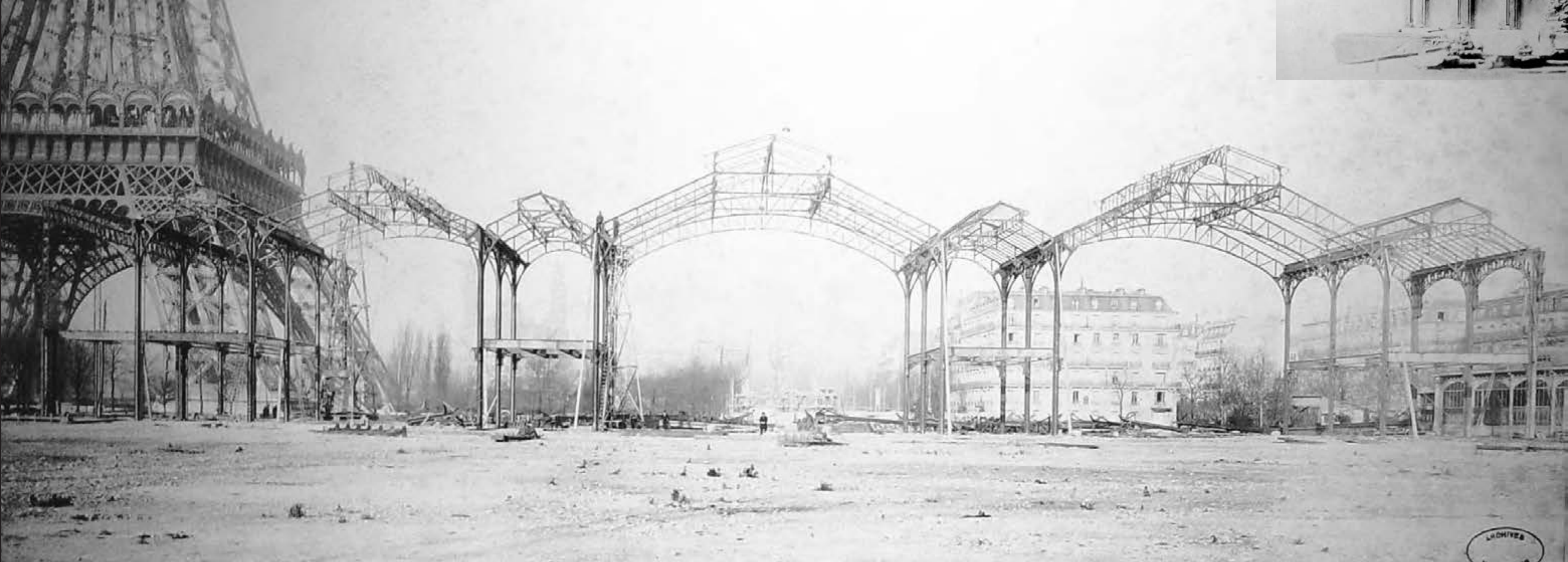
Exposition universelle de 1900 : le Palais des mines et de la métallurgie et la Tour Eiffel en construction.
