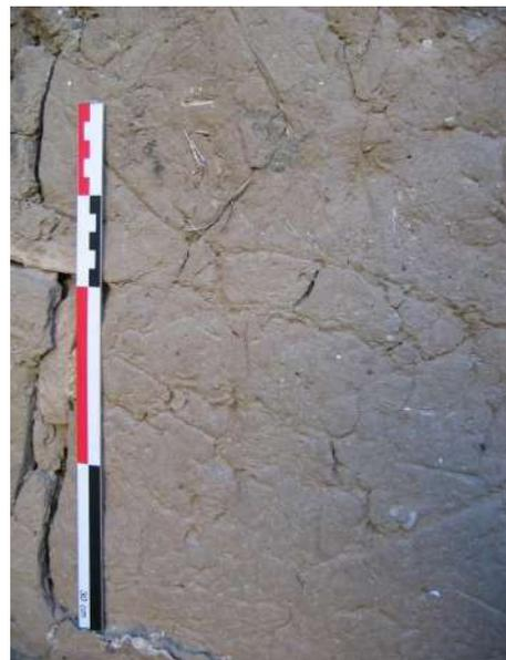
*Briques de terre crue moulée, disposées sur la façade sud-ouest du n° 4 impasse Victor Hugo, reposant sur un aménagement de terre massive. Cliché B. Morhain, 2008.*
