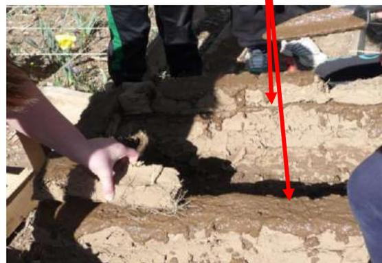
\* les murs sont enduits à l'extérieur et à l'intérieur de mortier de terre puis lissés à la main :
